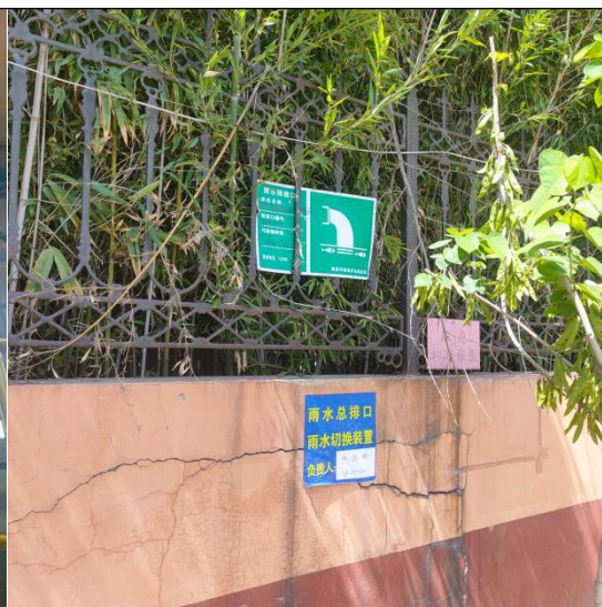
雨水排放口标识（DW001）
